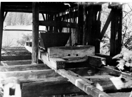
Nahore jednoduchá pila s náhonem na Horním Vsacku, dole interiér Jochcovy pily ve Stanovnici (MRV)
