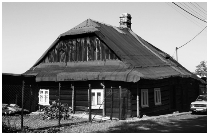
Ondrášova skryš v Raškovicích
